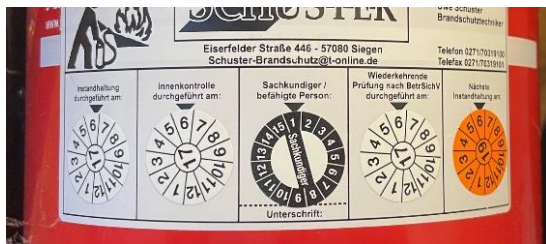
Abbildung 12 Prüfstempel des Feuerlöschers
